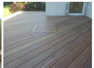
Terrasse Ipé sur structure bois et vis de fondations
